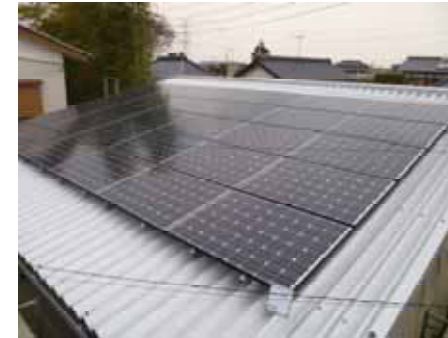
住宅用太陽光発電システムの施工現場 (茨城県つくば市)
